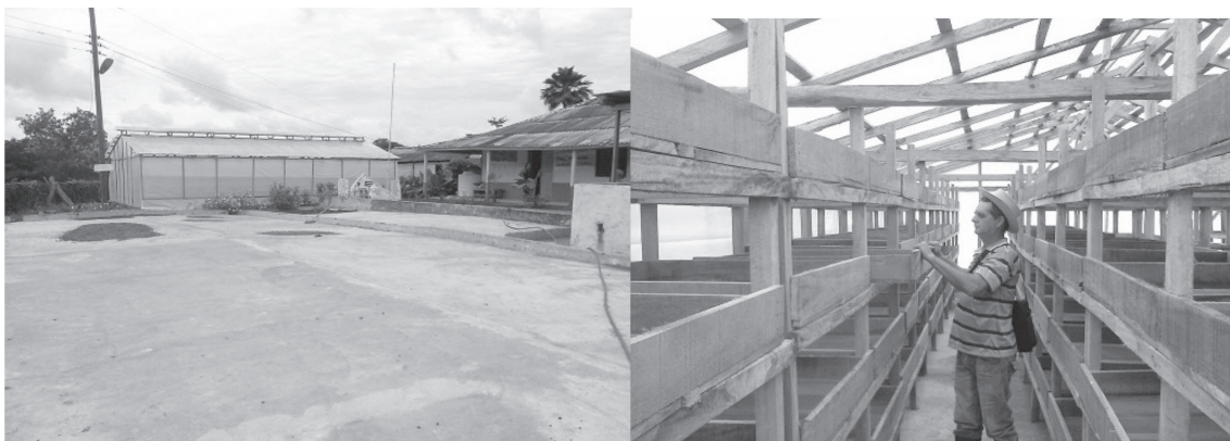
Figura 3. Secador solar, tipo invernadero, de café (vista exterior e interior).
